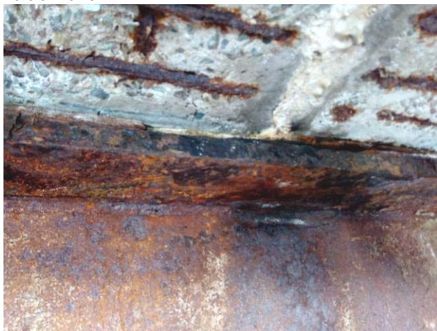
Obr. 4.14: Skutečný stav horní pásnice ocelového nosníku před měřením tloušťky.
