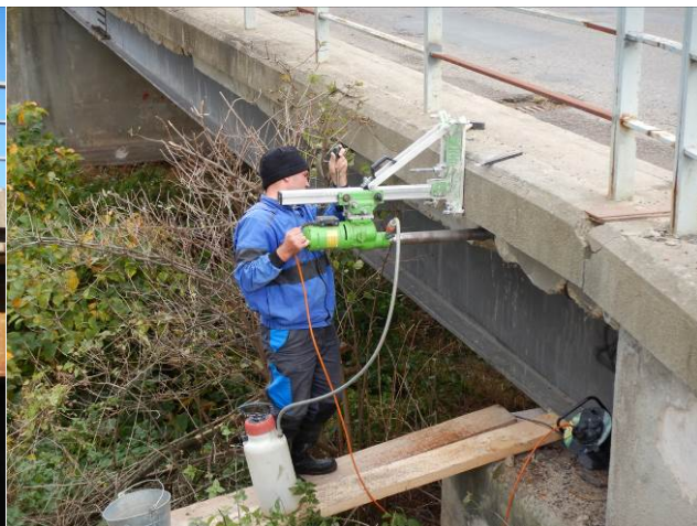
Obr. 4.3: Odběr jádrového vývrtu z monolitické desky v poli 1.
