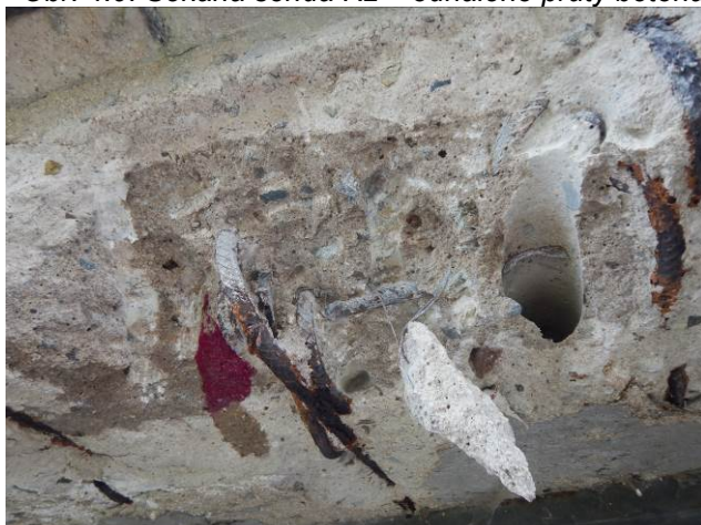
Obr. 4.10: Sekaná sonda K1 – panel NK.
