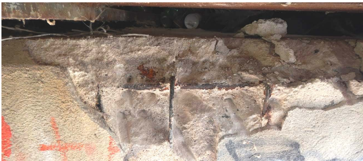
Obr. 4.9: Sekaná sonda K2 – odhalené pruty betonářské výztuže v úložném prahu opěry O4.
