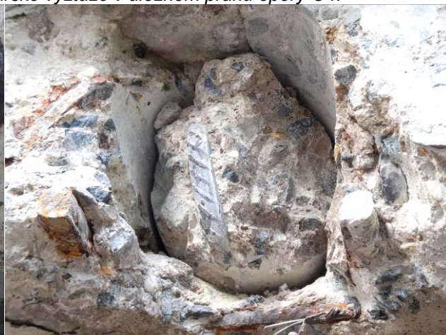
Obr. 4.11: Sekaná sonda K4 – monolitická deska.
