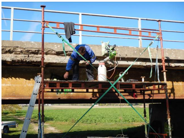
Obr. 4.2: Odběr jádrového vývrtu z panelu nosné konstrukce.
