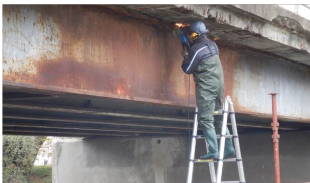
Obr. 4.12: Příprava profilu broušením na měření ultrazvukem.
